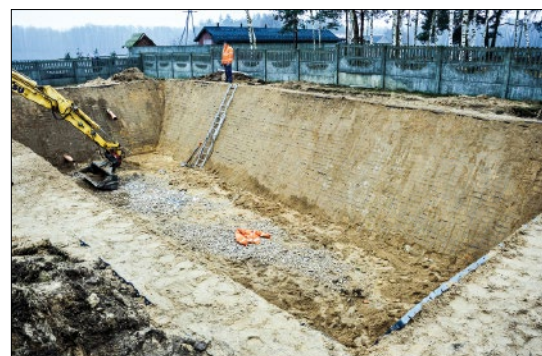
Prace przy zbiorniku chłonnym
