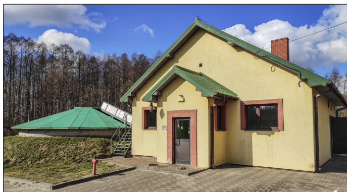
Oczyszczalnia ścieków w Zagórzach
