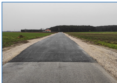
Wyremontowana droga z Annowa do Małej Woli
