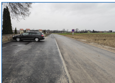
Przebudowana droga w Krzemienicy
