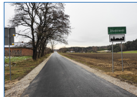
Droga w Studziankach po zakończeniu prac
