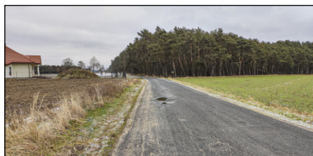
Fot. Odcinek drogi Mała Wola – Dzielnica do przebudowy
