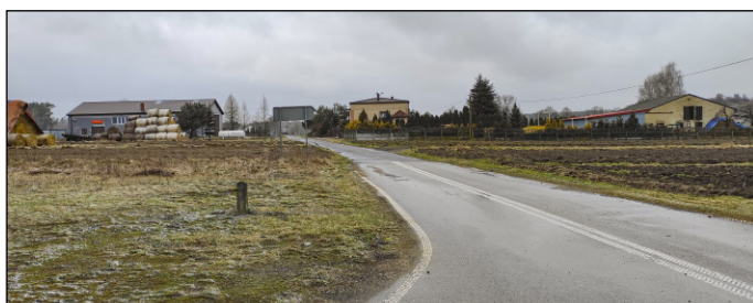
Fot. W Zubkach Dużych (Droga Górna) powstanie nowa linia oświetlenia ulicznego
