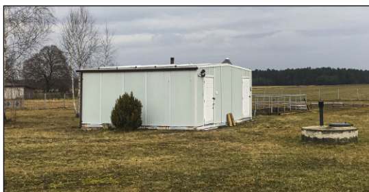
Fot. Obecna stacja uzdatniania wody
