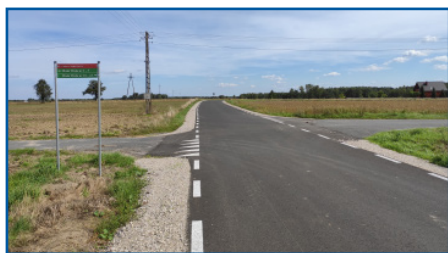
Fot. Zmodernizowana droga Mała Wola-Dzielnica
