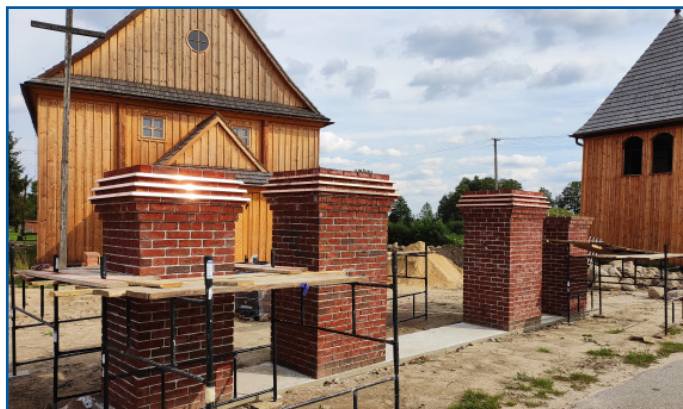
Fot. Remont ogrodzenia przy kościele w Czerniewicach
