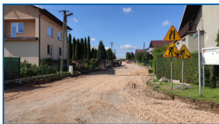
Fot. Przebudowa ul. Brzozowej w Czerniewicach
