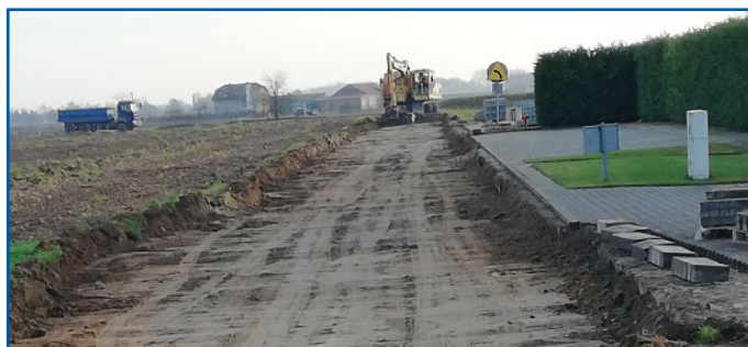
Budowa drogi przy ulicy Szkolnej w Czarniewicach i odcinka drogi w Chociw (tzw. Łuby)
