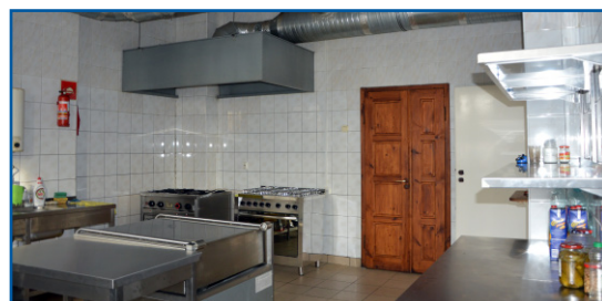
Wyremontowana kuchnia w świetlicy wiejskiej w Czerniewicach
