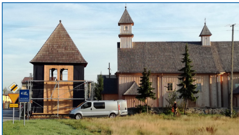
Remont drewnianej dzwonnicy w Czerniewicach
