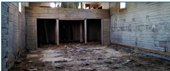
Zdemontowana podłoga w kościele w Czerniewicach; już wkrótce wykonana zostanie nowa
