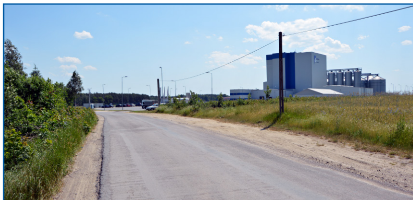
Droga przed przebudową
