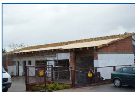
Prace budowlane przy garażach
