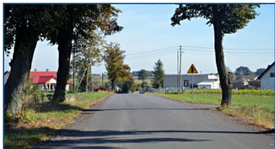
Ponad 3 km przebudowanej drogi biegnącej przez Stanisławów Studziński i Teodozjów
