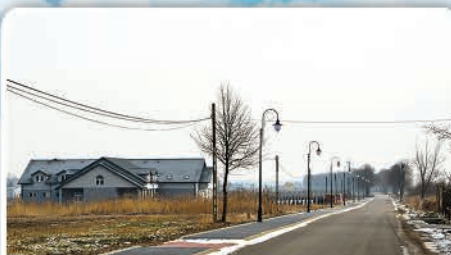
BUDOWA CHODNIKA PRZY ULICY WSCHODNIEJ W CZERNIEWICACH (WSPÓLNIE Z POWIATEM) I OŚWIECZENIA ULICZNEGO
