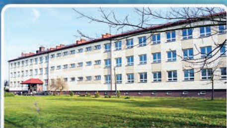
TERMOMODERNIZACJA BUDYNKU ZSIP W CZERNIEWICACH
