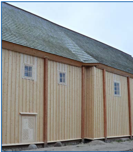
Nowe odeskowanie kościoła w Czerniewicach wraz z wymienioną stolarką okienną i drzwiową
