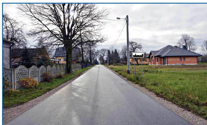
Przebudowana droga w Annowie
