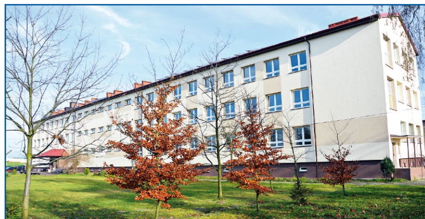
Budynek szkolny po zakończeniu prac termomodernizacyjnych, z wykonanym dociepleniem ścian zewnętrznych i nową elewacją; poprzednio docieplone były tylko dwie ściany zewnętrzne
