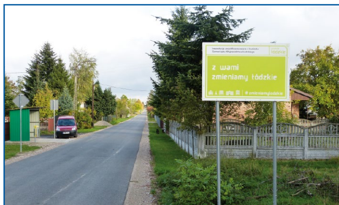
Przebudowana droga, biegnąca przez Dąbrówkę i Lechów
