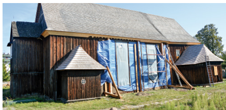
Konserwacja polichromii we wnętrzu kościoła w Czerniewicach oraz prace związane ze wzmocnieniem jego konstrukcji i kompleksowym remontem ścian
