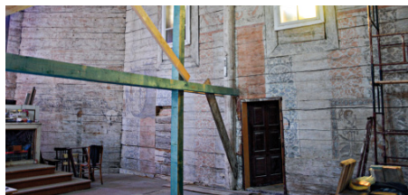
Konserwacja polichromii we wnętrzu kościoła w Czerniewicach oraz prace związane ze wzmocnieniem jego konstrukcji i kompleksowym remontem ścian
