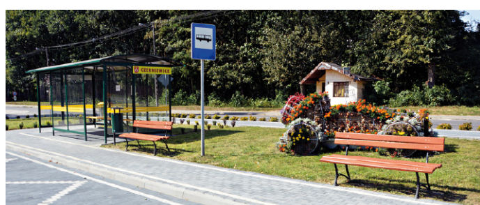
Nowy przystanek przy ul. Mazowieckiej
