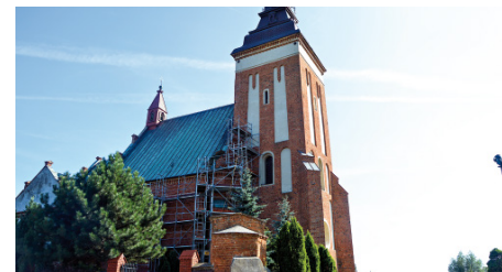
Prace przy elewacji krzemienieckiej świątyni
