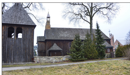
Kościół pw. św. Andrzeja Apostoła przed rozpoczęciem prac
