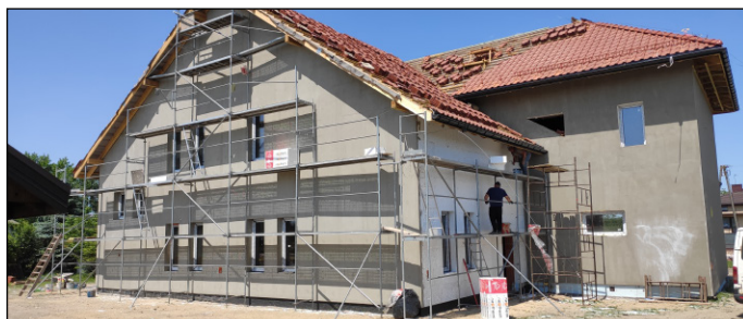
Stan prac przy OSP w Chociwiu
