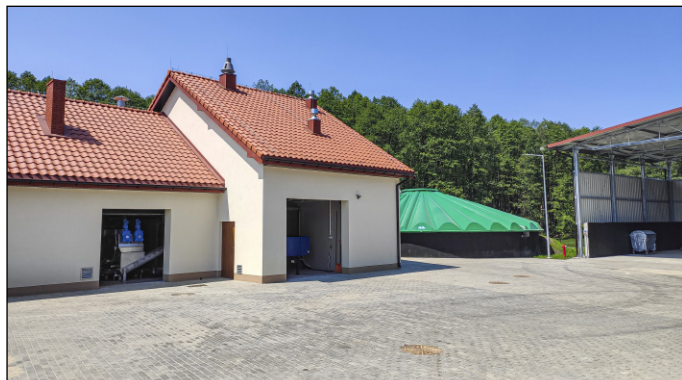
Teren oczyszczalni ścieków w Zagórach po zakończeniu I etapu prac
