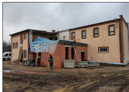
Remont budynku OSP Chociw
