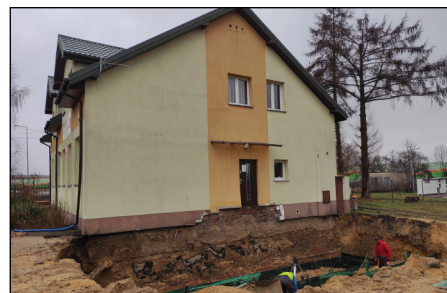
Remont budynku GCKRiBP w Czerniewicach
