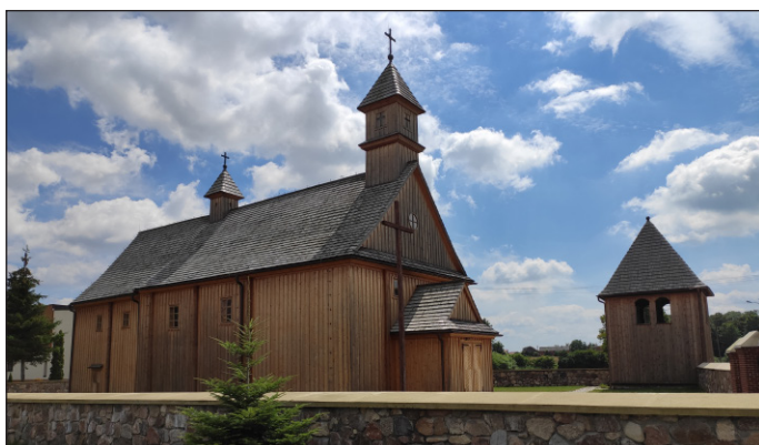
Kościół w Czerniewicach przed rozpoczęciem prac i po ich zakończeniu
