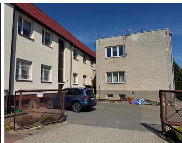
Budynek Urzędu Gminy w Czerniewicach (tył) - do modernizacji i zmiany funkcji
