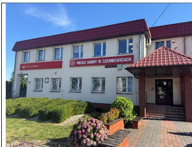
Budynek Urzędu Gminy w Czerniewicach (front)
