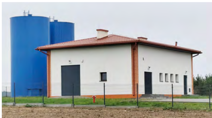
Zmodernizowana stacja uzdatniania wody w Chociwiu
