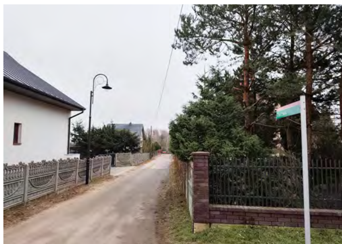
Nowo wybudowane oświetlenie na ul. Łąkowej w Czerniewicach
