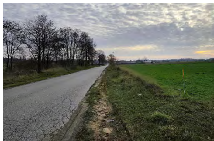
Droga od węzła w Wólce Jagielczyńskiej, której rozbudowa już się rozpoczęła
