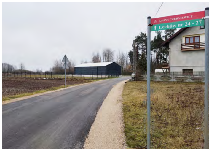
Przebudowana droga w Lechowie
