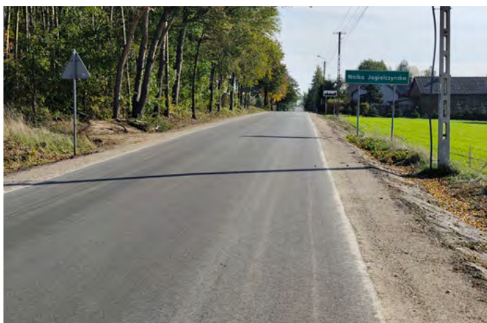
Droga od Turobowa przez Wólkę Jagielczyńską po modernizacji
