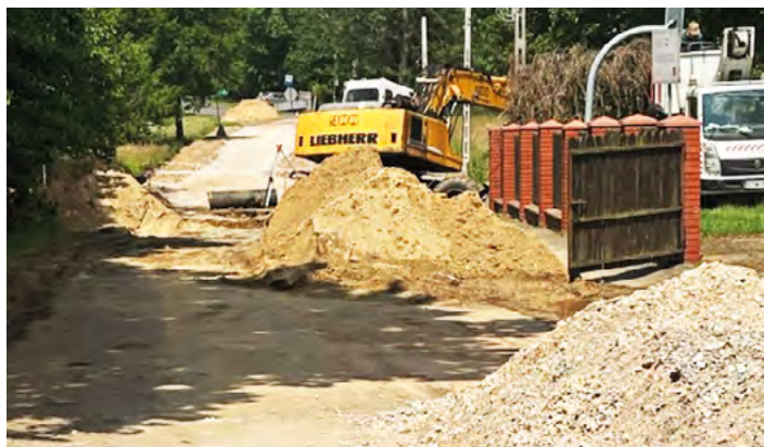
Budowa przepustu w Podkonicach Dużych
