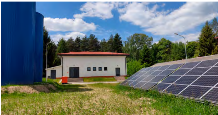
Stacja Uzdatniania Wody w Dąbrówce po modernizacji
