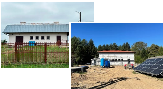
• Stacje uzdatniania wody w Dąbrówce i Chociw
