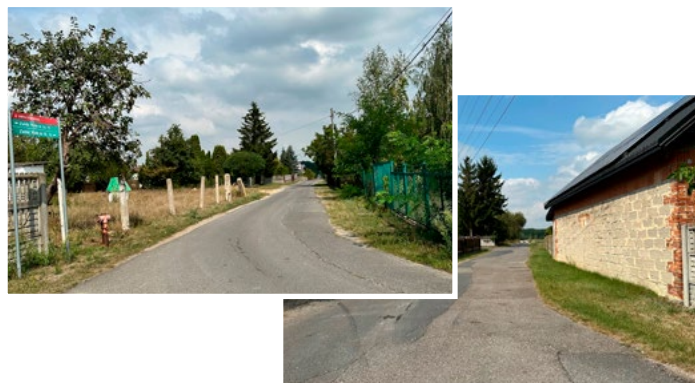
• Droga w Zubkach Małych przed przebudową
