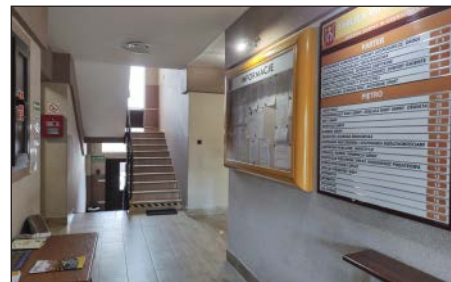
Nowa posadzka na korytarzu
