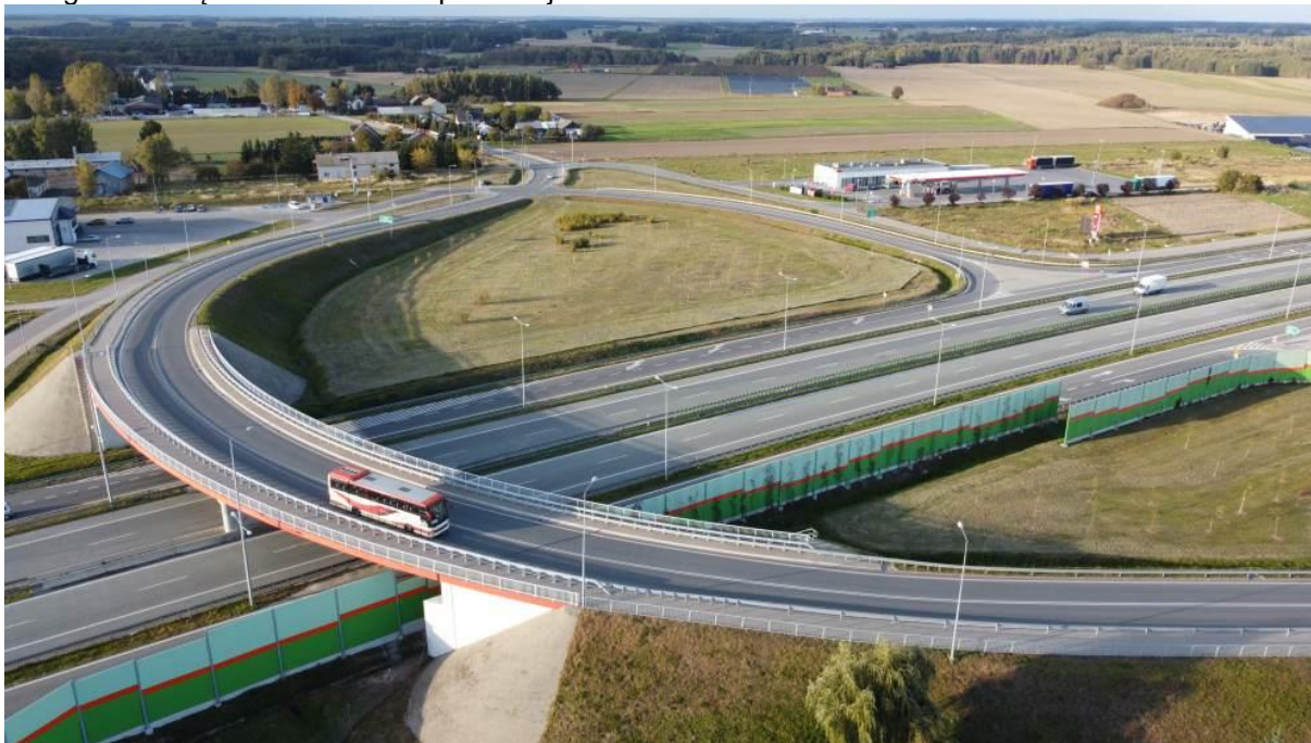
Fotografia 8 Węzeł na drodze ekspresowej S8
